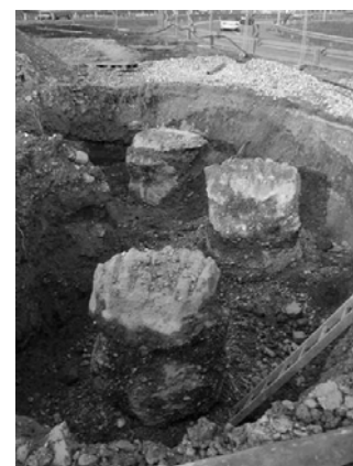
Bild 1. Freigelegte Probesäulen.
